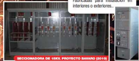
SECCIONADORA DE 15KV. PROYECTO BAVARO (2010)
