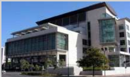
ILUMINACION DECORATIVA EDIFICIO SUPREMA CORTE DE JUSTICIA SANTO DOMINGO
